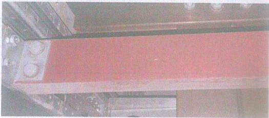
环氧树脂绝缘横梁照片
