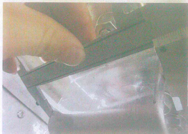
配电母排宽度照片
